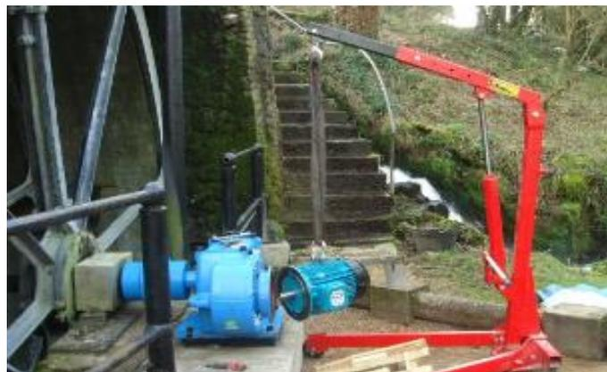
Figure 21 : Photo d'une roue par-dessus de 6m, rénovée pour la production d'électricité
