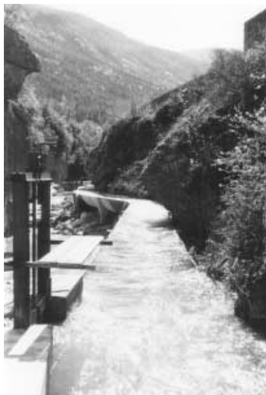
Canal d'amenée en éléments préfabriqués.
