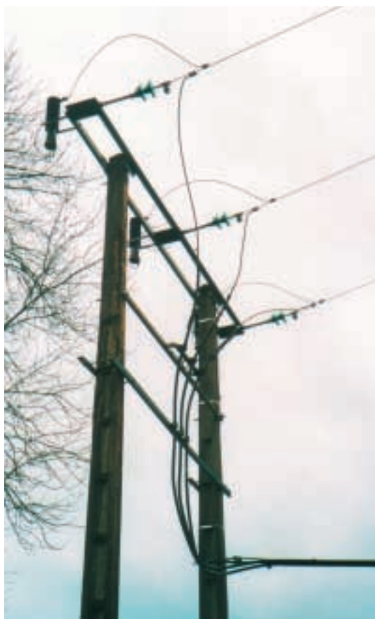
Départ en 20 000 volts avec parafoudres
