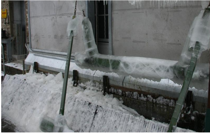
Figure 3: Exemples de grilles colmatées par de la glace (à gauche) et des galets (à droite), où la prise en compte du poids du colmatage semble importante.
