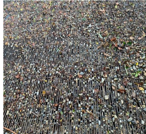
Figure 3: Exemples de grilles colmatées par de la glace (à gauche) et des galets (à droite), où la prise en compte du poids du colmatage semble importante.
