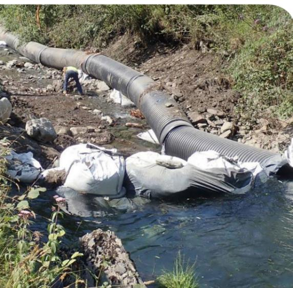
Exemples de mises à sec de la partie en travaux par busage
