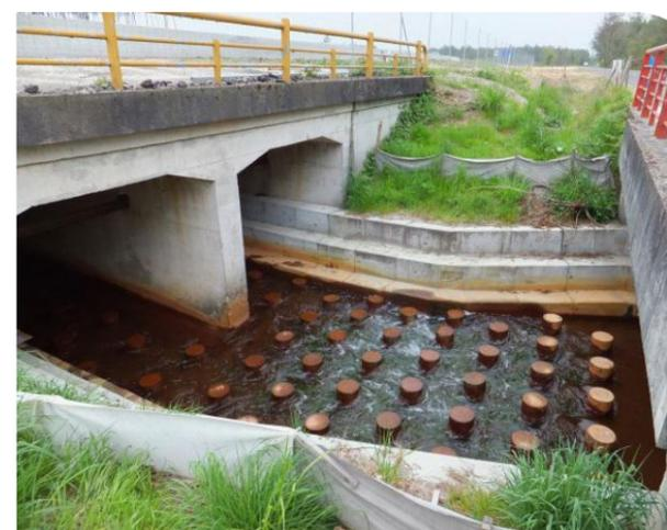
**Vue en coupe et de haut de l'ouvrage et des dispositifs permettant de « casser » le courant**
