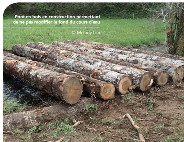
Pont en bois en construction permettant de ne pas modifier le fond du cours d'eau
