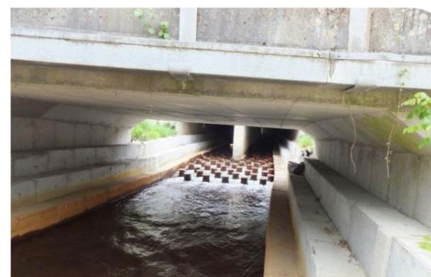
**Double cadre réhabilité sous l'A63 avec trois banquettes pour le passage de la faune et des plots dans le fond du lit réduisant la vitesse du courant**
