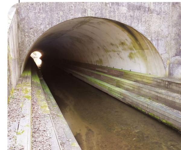
En plus des prescriptions précédentes, il est possible d'améliorer la stabilité du lit et de « casser » le courant d'un ouvrage soumis à de forts débits par la mise en place de dispositifs réduisant la vitesse du courant (voir ci-dessous). Cela permet aussi d'augmenter la lame d'eau.
