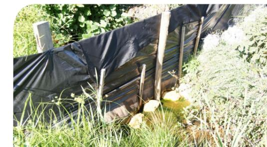
Dans tous les cas, il faudra veiller à enterrer le système de clôture sur 10 à 20 cm afin d'assurer l'étanchéité du dispositif. Dans les zones en eau, des dispositifs particuliers doivent être adaptés pour empêcher le passage des individus tout en assurant la circulation hydraulique. Si un grillage doit être utilisé, la maille devra impérativement être inférieure à 15 mm.
