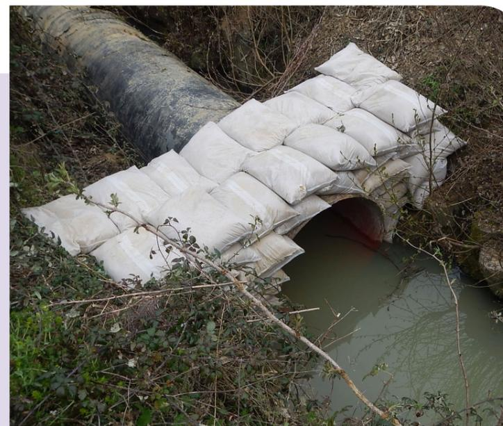
Exemples de mises à sec de la partie en travaux par busage
